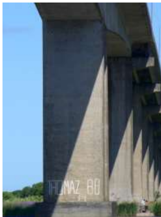
Detalhe pilar P1202 face Rio Grande
