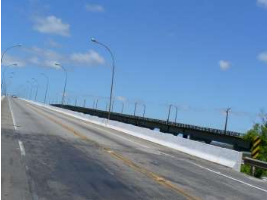
Barreira rígida lado direito obra observador Pelotas
