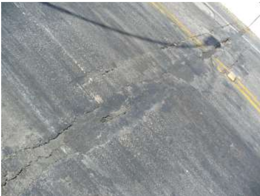
Detalhe junta entrada obra
