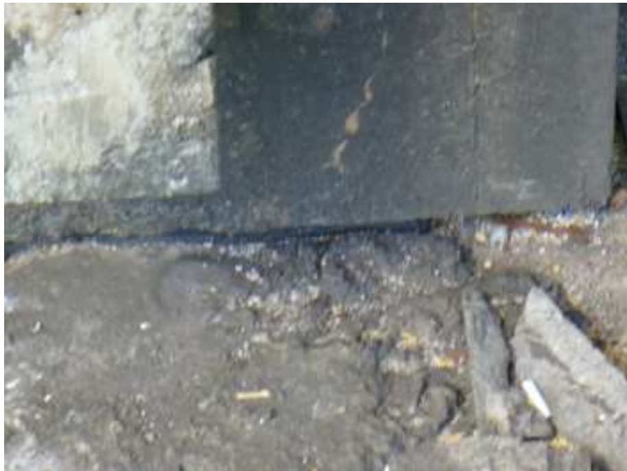
Detalhe neoprene apoio N0211
